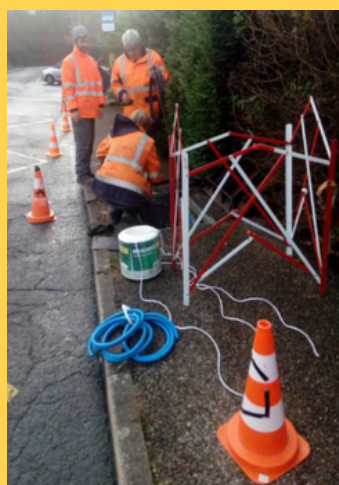
Pose d'une ficelle dans les fourreaux
