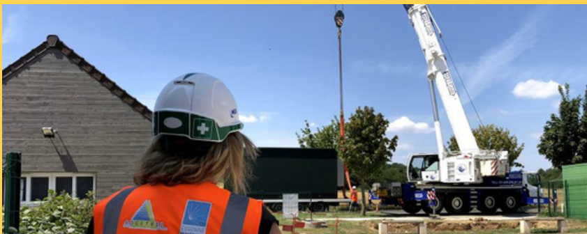
Pose d'un Nœud de Raccordement Optique (NRO) à l'aide d'une grue
