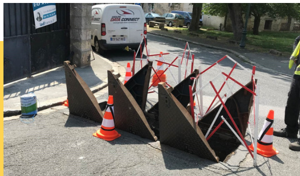
Ouverture d'une chambre sur chaussée pour effectuer des aiguillages de fourreaux
