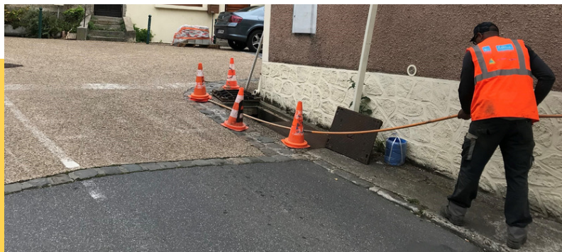
Aiguillage de fourreaux pour préparer le passage de la fibre optique
