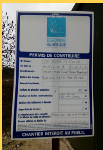
Panneau d'information pour la pose d'un NRO
