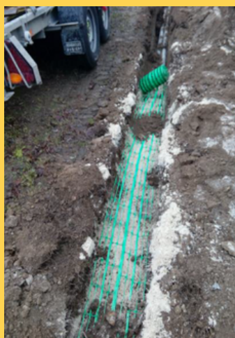
Déroulage du filet indicateur d'une tranchée
