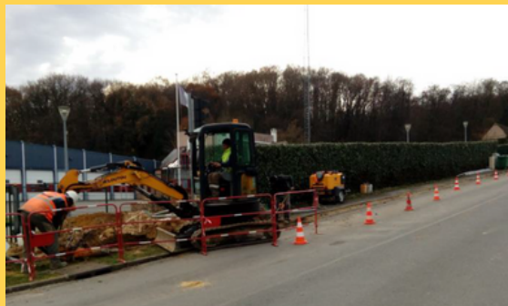
Travaux de génie civil pour la réalisation d'une tranchée et la pose de fourreaux
