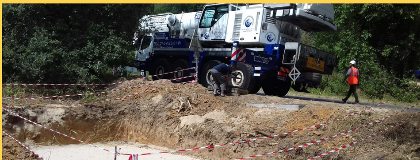
Préparation de l'opération de levage d'un NRO à l'aide d'une grue de plus de 50 mètres de hauteur.
