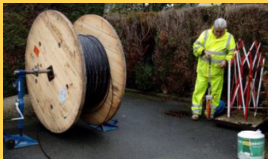
Tirage dans les fourreaux d'un câble optique depuis un touret
